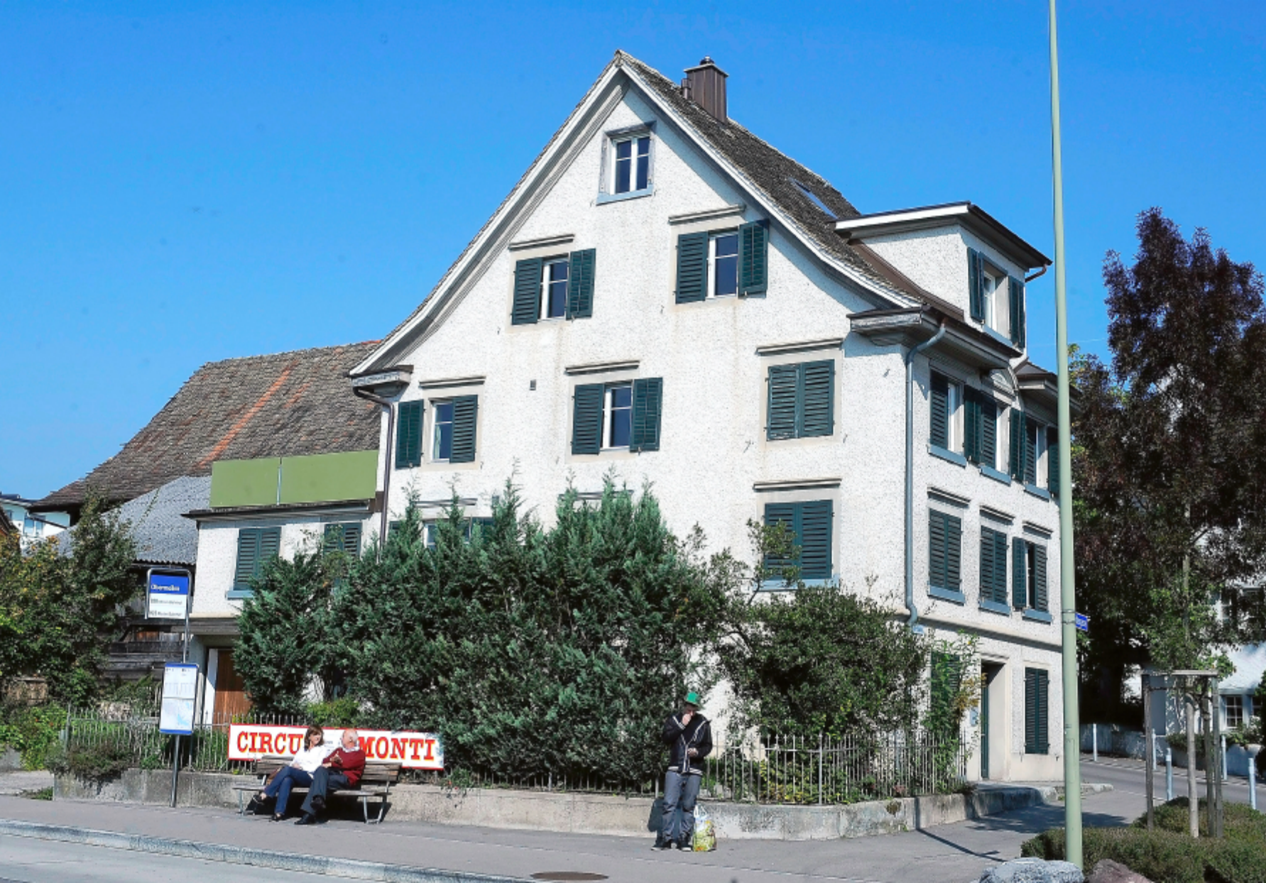
Der Seidenhof an der Seestrasse 831 wird in den kommenden Wochen saniert, ehe die neuen Bewohner einziehen. Foto:Reto Schneider
